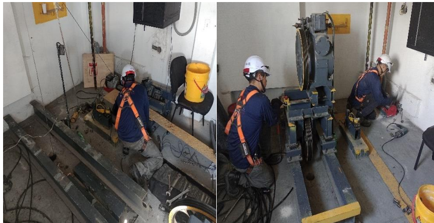
Desinstalación y desmontaje de los componentes del ascensor
