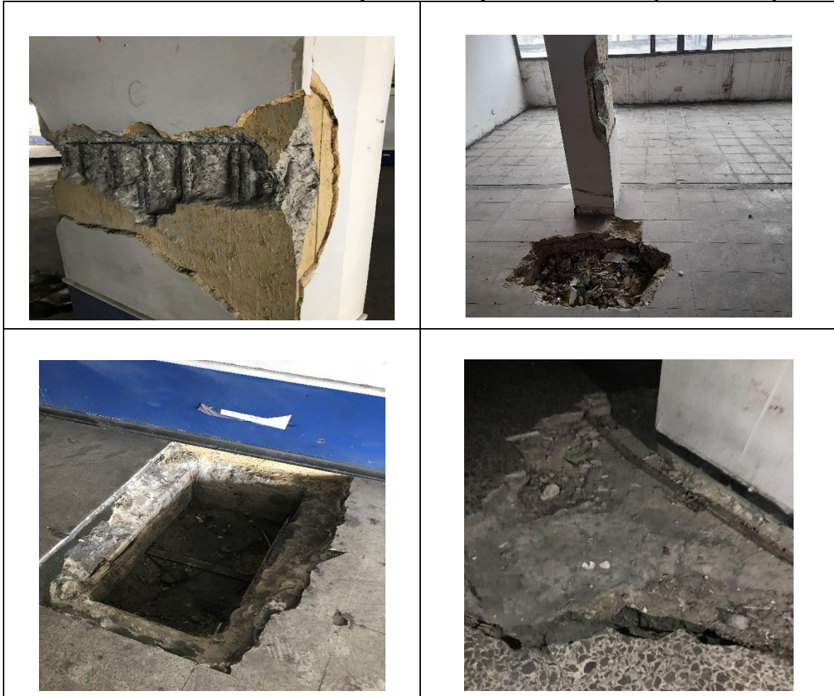
Gráfico No. 19 - Registro fotográfico del estado actual de algunos de los elementos del Edificio El Comendador sujetos a ensayos destructivos (11-oct-2023)
